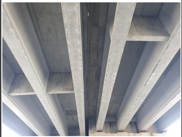
거더 및 가로보 전경
