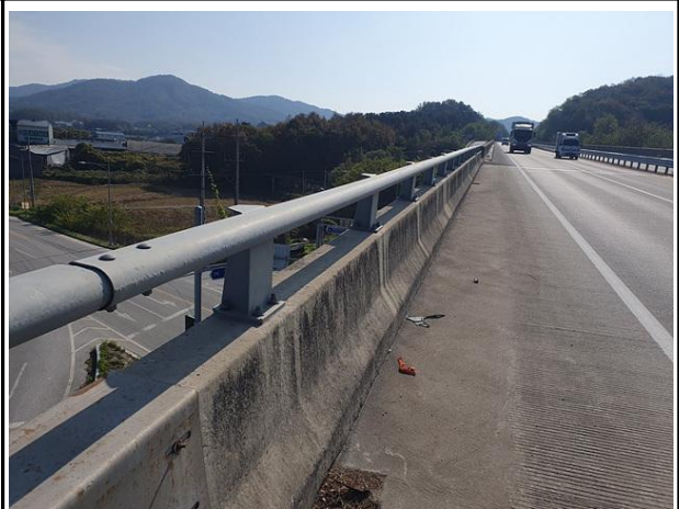
난간 및 연석 전경
